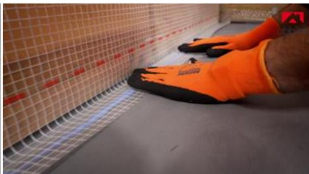
Pour les relevés sur mur, faire remonter la membrane sur 10 cm minimum sur le mur d'élévation et utiliser *Colle pare-vapeur Ubbink* pour réaliser le raccord.
